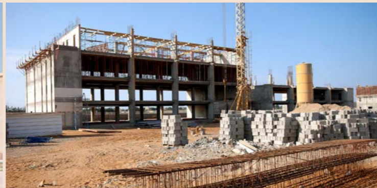
Chantier Technopolis à Rabat - Salé.
