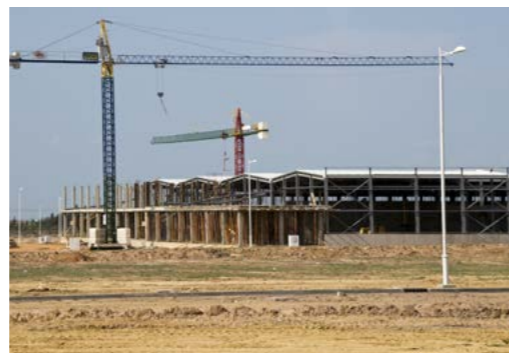
Visite du site d'Atlantic Free Zone – Usine en construction
